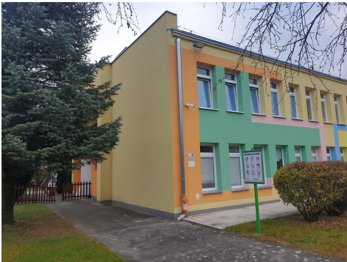
Zdjęcie 3. Stan istniejący – strona zachodnia
