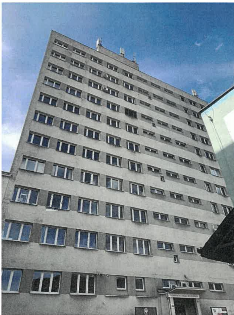
Zdjęcie 1 Badany obiekt
